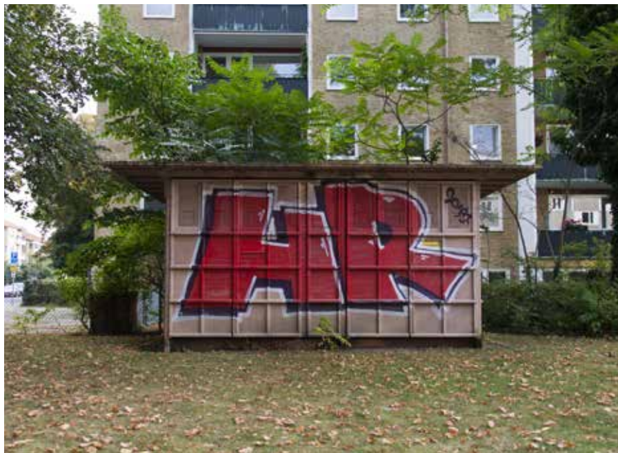
Klottersanering som är skonsam mot både fasad och miljö.
